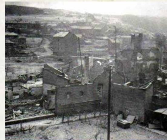
Stavelot in Trümmern
